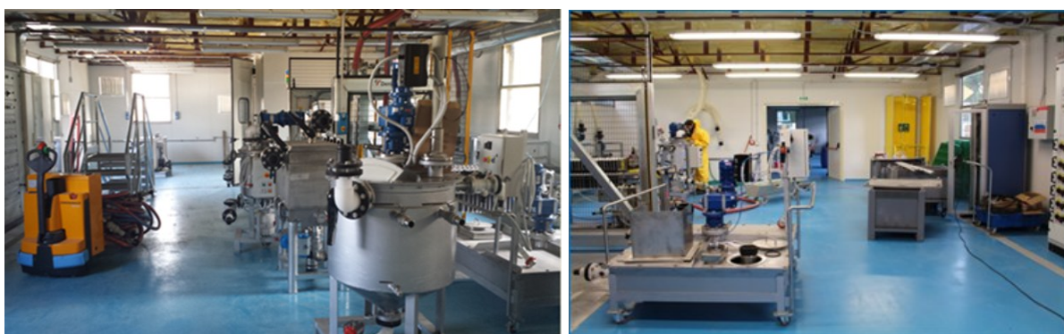
Figura 2. Impianto ROMEO: una panoramica
