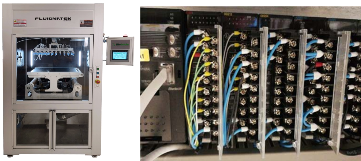
Figura 1. a) Tipologia dell'infrastruttura di fabbricazione AEM basata su sistemi di elettrofilatura Bionicia ; b) sistema di controllo e morsettiere del PLC SIEMENS, inclusa scheda ethernet
