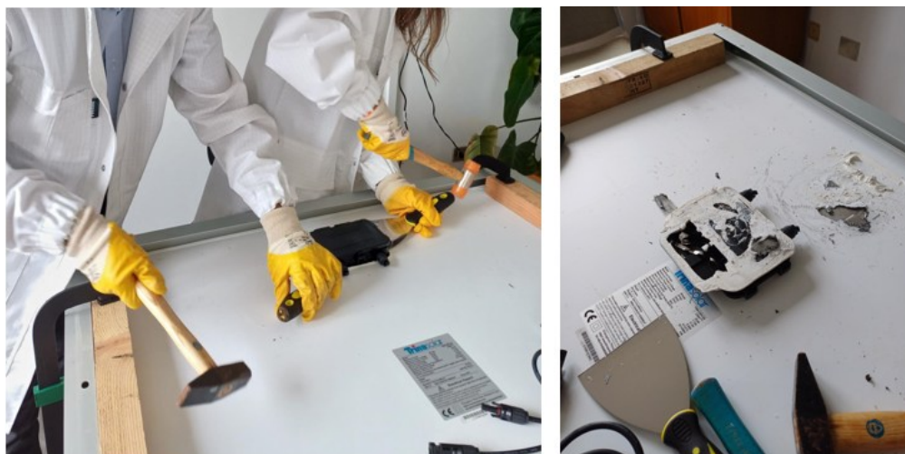
Figura 44: Smontaggio della scatola di giunzione dal retro del pannello fotovoltaico
